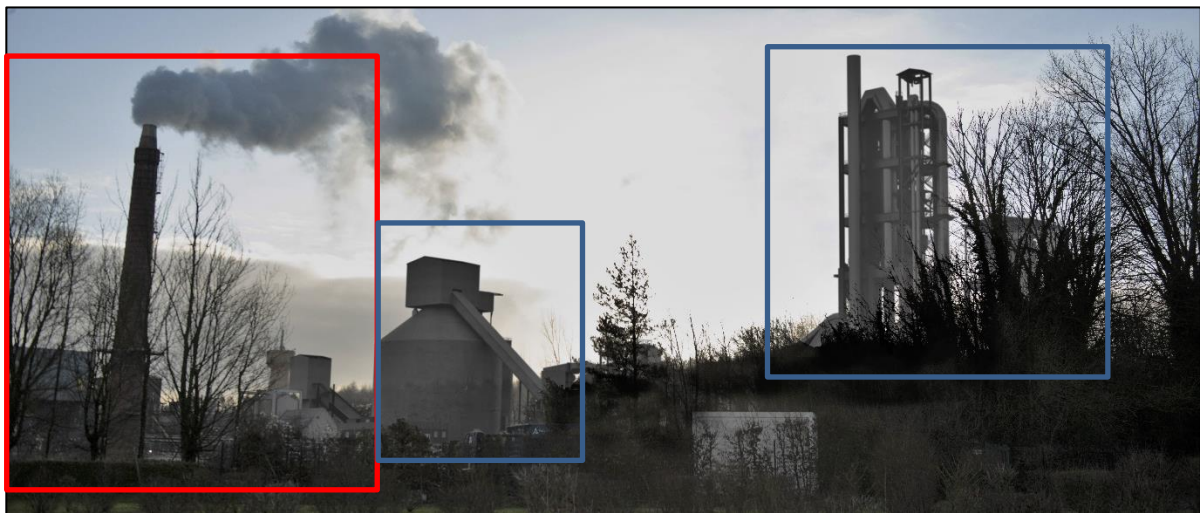
Vue en direction du site depuis le rond-point permettant de rejoindre la rue Macaux (Nord) (8)
